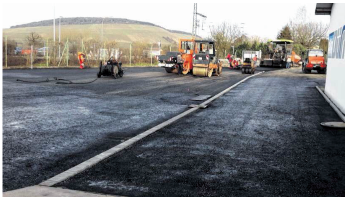
Mit der Asphaltierung wurde die Sanierung der unteren Hoffläche der Christoph Dürr GmbH in Lauda abgeschlossen. Die Maßnahme beinhaltet auch den Austausch der Rohrleitungen, der Kanaleinläufe und des Sperrschiebers.
