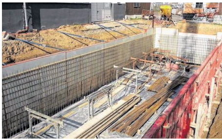
Das neue Löschwasserbecken wurde am Standort des alten gebaut. Über dem Becken befinden sich nun Parkplätze.
